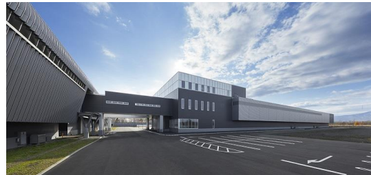
石狩データセンター3号棟（右側）
